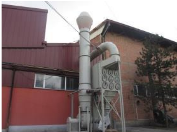
Слика 1: Филтер за прашина Donaldson Optiflo во одделение за лиење на решетки
