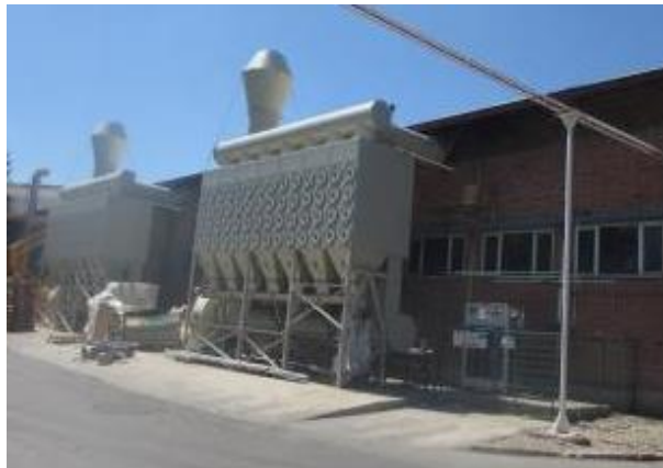
Слика 2: Филтер за прашина American Air filter во одделение за монтажа на акумулатори
